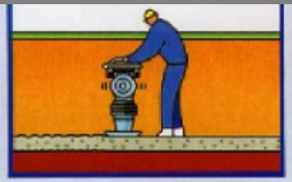
2. Подготовка грунтового основания
